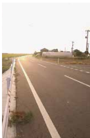
町道16号吉岡～廻館線
